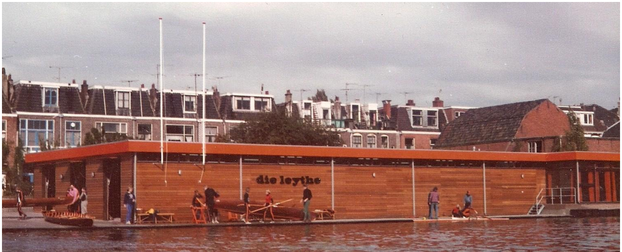
De nieuwe loods, officieel in gebruik genomen. De omhoog en naar binnen opklappende deuren zijn later vervangen door naar boven oprollende jaloeziedeuren.
